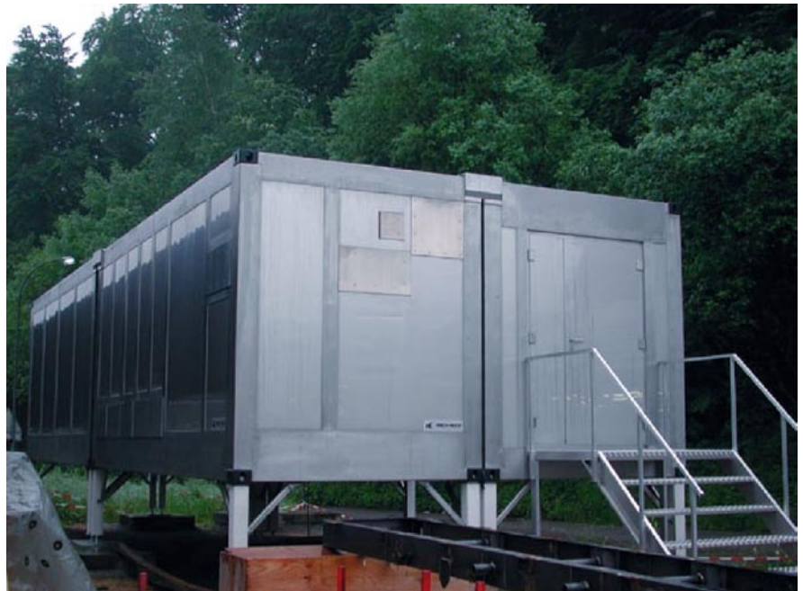
Bild 4: Container für die Überwachung des Zugverkehrs im Lötschbergtunnel
