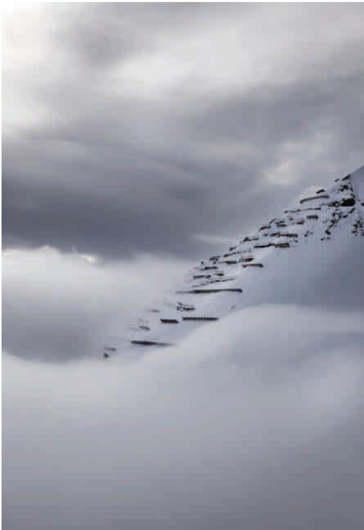
Lawinverbauungen an der Ostflanke des Schiahorns, GR. | Avalanche barriers on the eastern flank of the Schiahorn.
